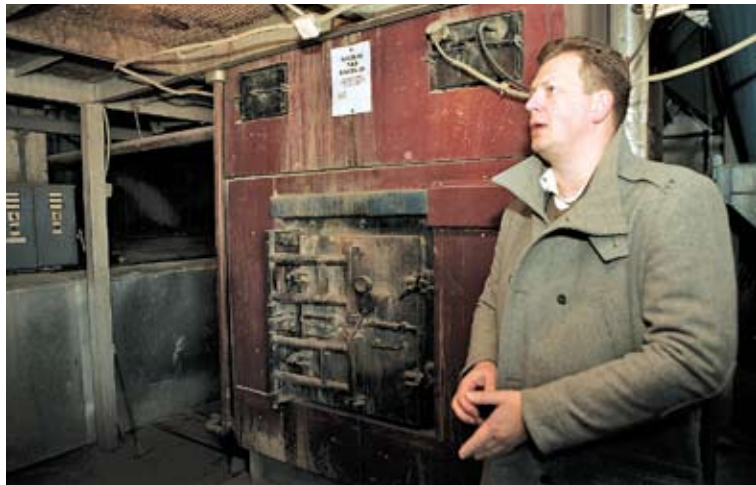
„Prienų energijos“ direktorius V. Povilėnas pasakoja, kad biokatilo našumas šiandien tik 50 proc., todėl vandens šildymui naudojami dar du dujiniai katilai, kurie brangina gamybos kaštus
